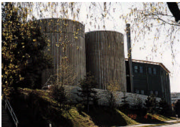
Fig.5 Biogasanlage der E. Flachsmann AG in Wädenswil
