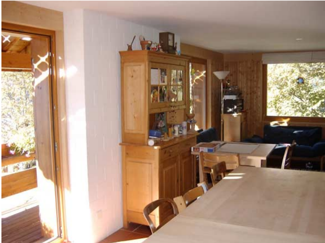
Abbildung 2-14: Murokauste aus Kalksandstein als Rücklaufkanal zum Kollektor. Ansicht vom Wohnzimmer. Gut sichtbar sind ausserdem die vollverglasten Türen auf den Südbalkon und das Licht-/Schattenspiel der Photovoltaik.
