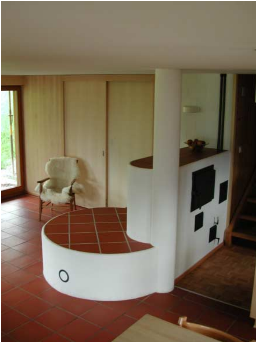
Abbildung 2-17: Ofensatellit im Wohnzimmer. Primärer Speicher und Wärmeabgabe, sowie integriertem Backofen und Warmwasserregister.
