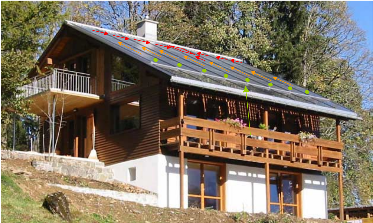
Abbildung 2-6: Durchströmung des Solardaches. Im Vordachbereich gut sichtbar die semitransparente Photovoltaik mit ihrem Lichtspiel an der Fassade.
