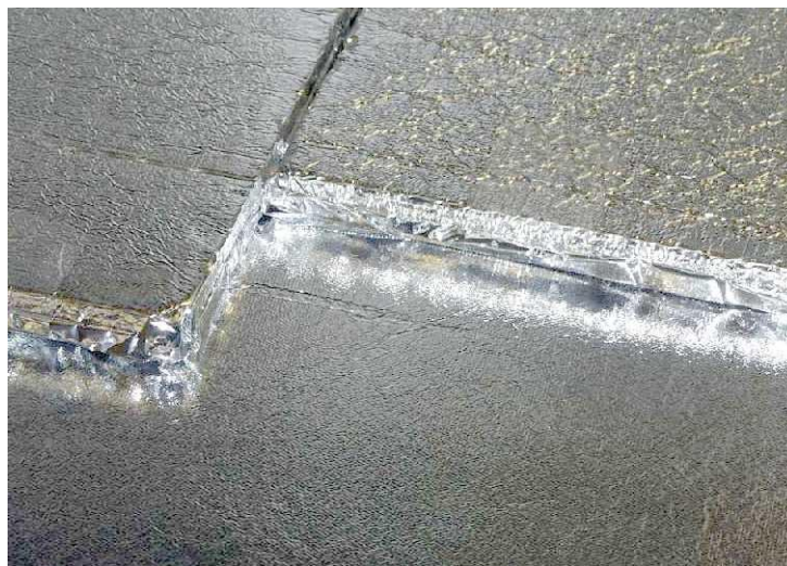
Fig. 1: VIP-Paneele für den Baubereich bestehen aus einem nanoporösen Kernmaterial (z.B. pyrogene Kieselsäure) mit niedrigem Innendruck und einer möglichst gasdichten Hüllfolie (meist laminierte Aluminiumfolie oder metallbedampfte Kunststofffolie) mit verschweissten Rändern.
