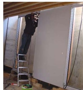
Fig. 2: Fassade mit vorgefertigten Vakuumdämmelementen in Binningen / Schweiz (Architekt: Feiner Pestalozzi, Basel; Fassadensystem: Häring AG, Schweiz)
