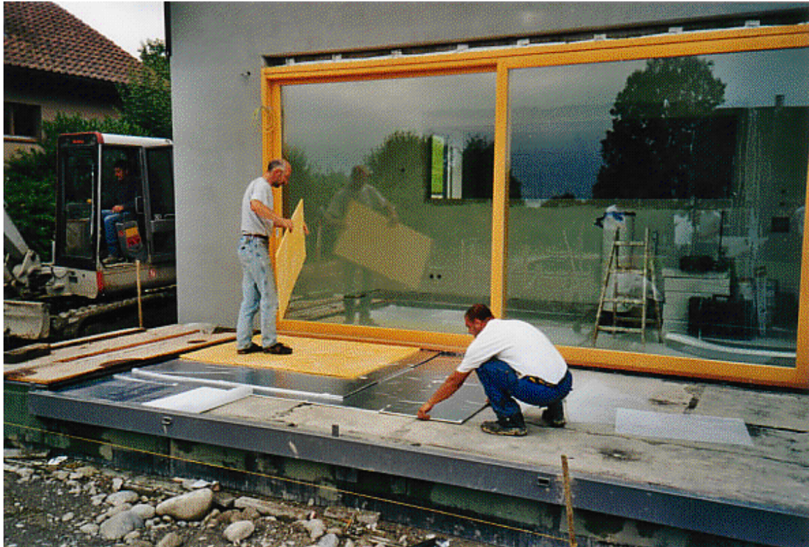
Fig. 2: „Klassischer“ Einsatz von VIP direkt auf der Baustelle, für den derzeit häufigsten Einsatzzweck, um Terrassen zu dämmen, bei Vermeidung von Niveau-Unterschieden zwischen innen und aussen (Foto: ZZWancor)
