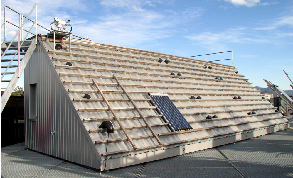
Abbildung-1: Das Schrägdach des Systemdachlabors ist 45° geneigt und nach Süden ausgerichtet. Die Kollektoren für einen Systemtest werden auf dem Schrägdach installiert. Die Kollektorkreisleitungen werden direkt in die Testkabine geführt. Auf dem Flachdach können Thermosiphonsysteme mit Unterkonstruktion aufgestellt werden.
