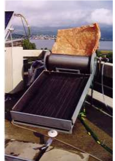
Figure 5 : photo du système thermosiphon étudié
