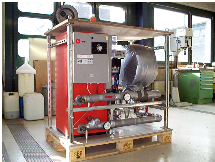
Figure 1: Vue du module de chauffage en cours de montage sur une palette CFF avec le cadre rigide de protection et l'isolation de la tuyauterie.
