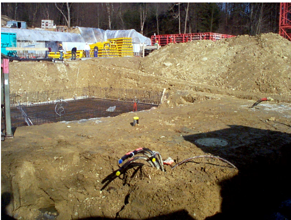
Figure 2 : Détail de la sonde géothermique avant l'installation et vue du chantier
