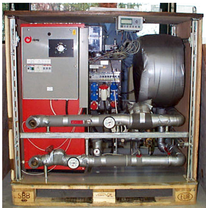
Figure 2: Module de chauffage terminé avec les panneaux de protection. Au centre le coffret électrique et en haut le data-logger.
