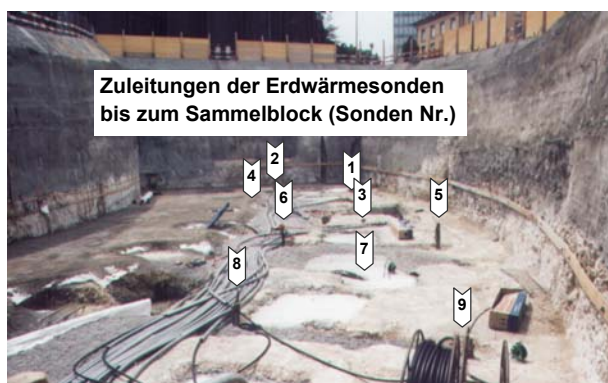
Verlegte Sonden auf der Bausohle, Sammelblock
