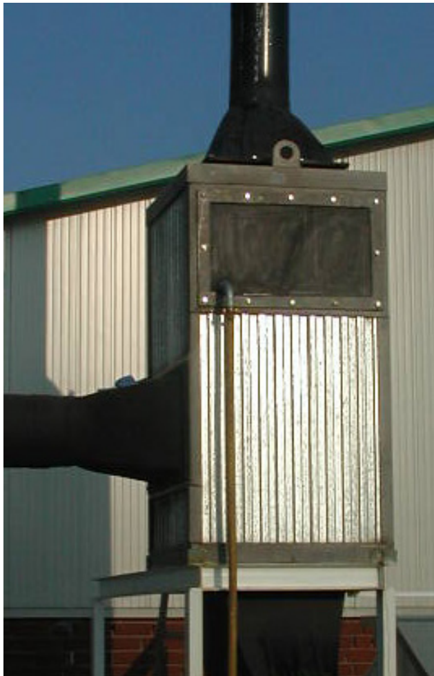
Abb. 3.2.2.1 Der Multizyklon der Firma Sugimat ist aus mehrere Mini-Zyklons aufgebaut und sollte den Staubgehalt auf 100 mg/nm 3 vermindern.
