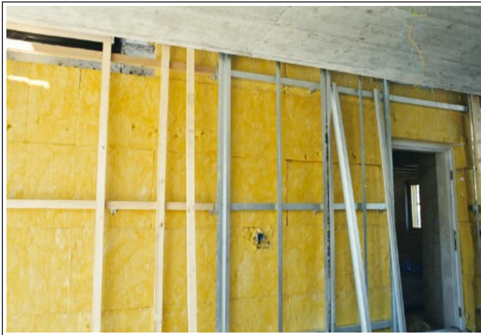
Schritt 13: Montage der F60 Abschlüsse im Bereich der Treppenaufgänge auf Basis des Ankersystems.
