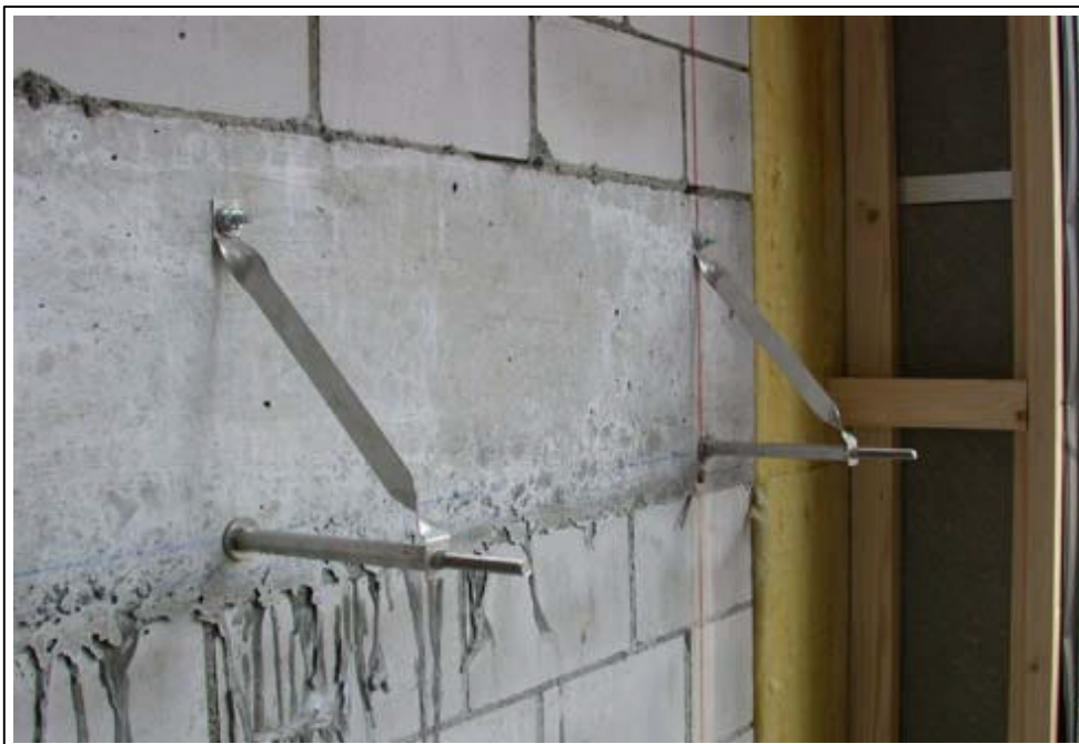
Schritt 2: Bohren und Setzen der Unterkonstruktionsanker Typ A zur Aufnahme der vertikalen Lasten (Eigengewicht) in der Betondecke.
