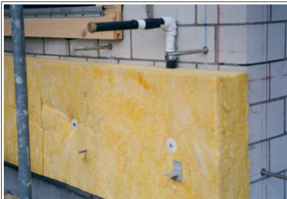
Schritt 5: Montage der 1. Lage Mineralwollplatten mit einer Stärke von 180mm .
