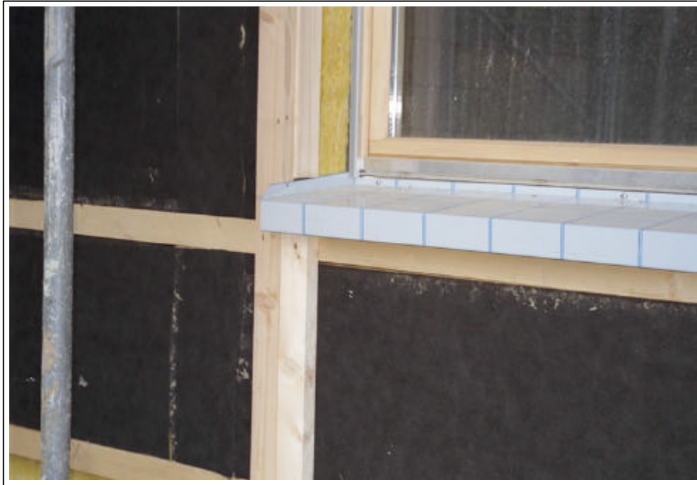
Schritt 10: Montage der Fensterbänke mit Schutzfolie und Haltebügel.
