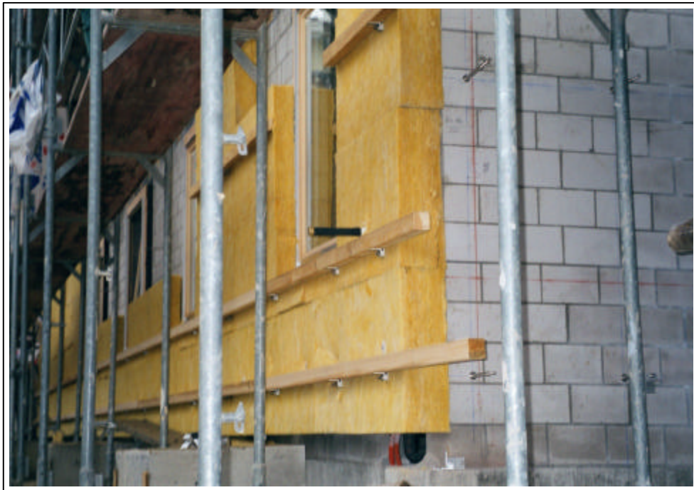
Schritt 7: Montage der horizontalen Holz-Grundlattung auf die Aluminium- Aufnahmehalter des Ankers, mit der Dimension 60/60mm .
