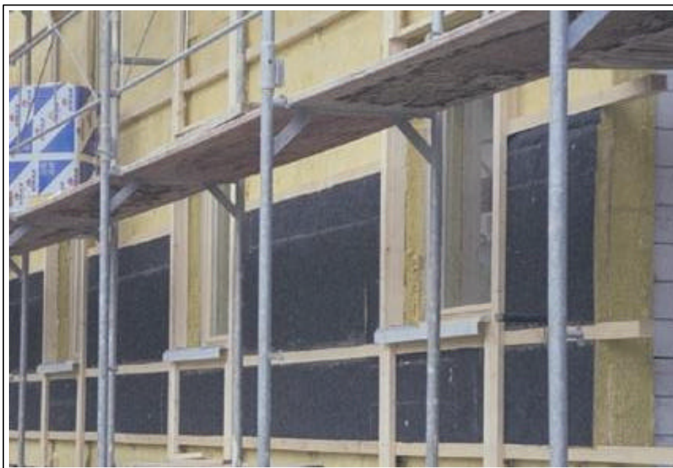
Schritt 8: Montage der 2. Lage Mineralwollplatten mit schwarzem Vlies und einer Stärke von 60mm .
