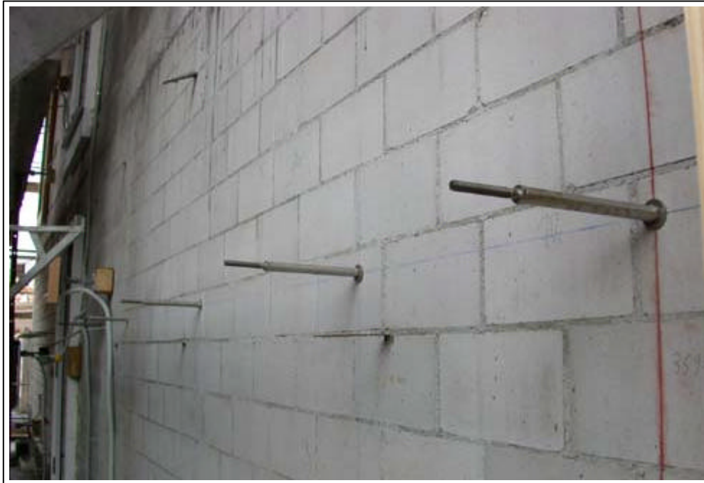
Schritt 3: Bohren und Setzen der Unterkonstruktionsanker Typ B zur Abtragung der horizontalen Lasten (Winddruck und -sog) in Mauerwerk.
