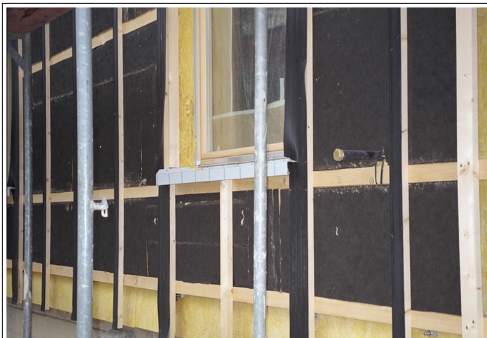
Schritt 12: Montage von schwarzen Fugengummibänder
