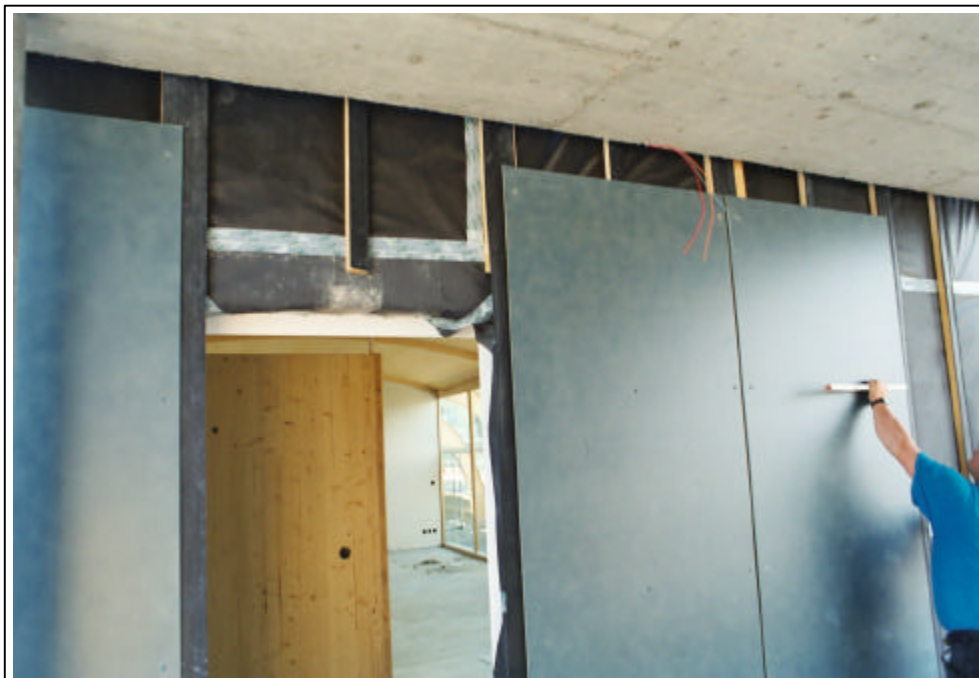
Schritt 16: Montage und Verschraubung der fertig zugeschnittenen und bearbeiteten Faserzementplatten.
