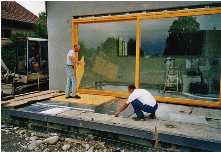
Fig. 3: „Klassischer“ Einsatz von VIP direkt auf der Baustelle, für den derzeit häufigsten Einsatzzweck, um Terrassen zu dämmen, bei Vermeidung von Niveau-Unterschieden zwischen innen und aussen (Foto: ZZ Wancor).
