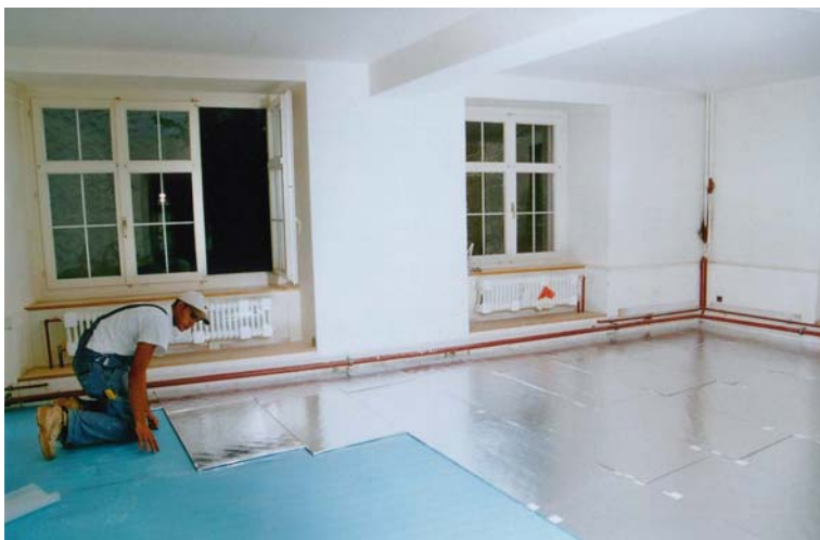
Fig. 4: Einsatz von VIP direkt auf der Baustelle bei Renovationen, für den platzsparenden Einbau in Bodenkonstruktionen (Foto: ZZ Wancor).
