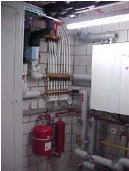
Bild 3-7 Heizungsinstallation (Bild www.FutureLife.ch )
