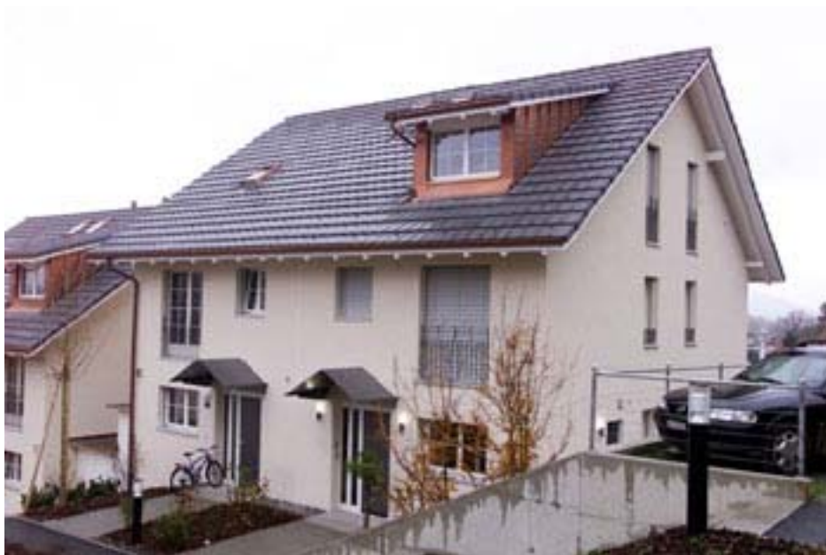
Bild 3-2 Haus Ansicht Rückseite (Bild www.FutureLife.ch )
