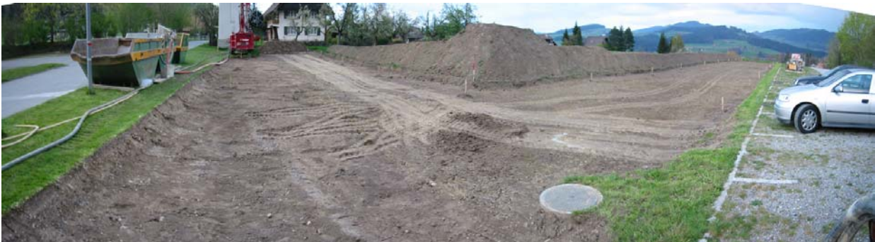
Bild 2: Das abhumusierte Erdsondenfeld vor den Bohrarbeiten. Im Hintergrund das Bohrgerät Links die 3 Mulden für die Bohrschlammentsorgung. 2 davon dienten als Absetzbecken.
