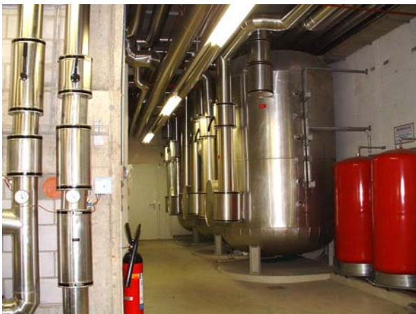
Bild 7: Die beiden Pufferspeicher 5'000 ltr für die Wärmepumpen und im Hintergrund der Speicher für den Ölheizkessel
