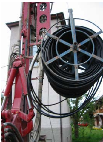
Bild 3: Vor dem Einbringen der Sondenrohre
