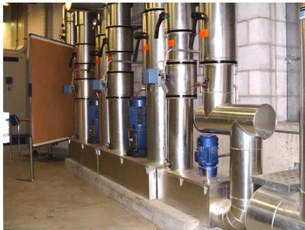
Bild 6: Der Sondenverteiler mit den beiden Solepumpen und der Free- Coolingpumpe
