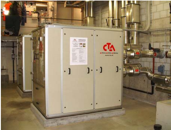
Bild 5: Die beiden Wärmepumpen mit den Anschlussleitungen
