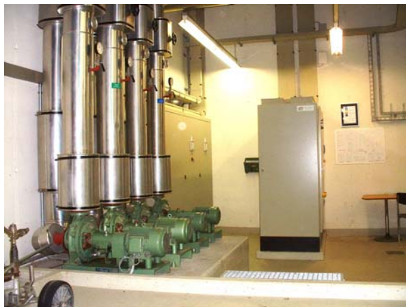
Bild 8: Die Fernleitungspumpen mit den Schaltschränken im Hintergrund
