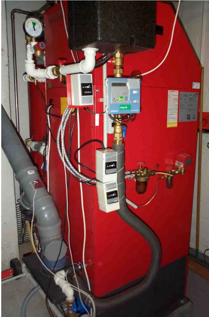
Fig. 2: Beispiel eines mit Messgeräten ausgerüsteten Ölkessels
