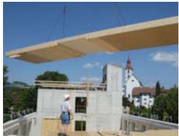
Montage der Bodenelemente.
