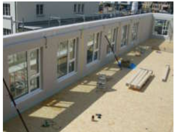
Montage der Wandelemente.
