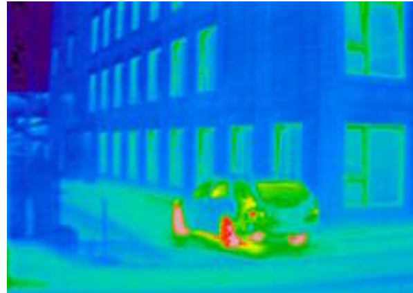
Gebäude von Südosten betrachtet: es sind keine signifikanten, wärmetechnischen Schwachstellen oder Luftundichtigkeiten sichtbar.
