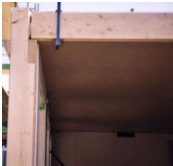
Auflage Decke bei Aussenwand auf Kerto Unterzug.
