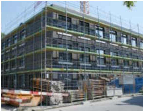
Innerhalb von nur 4 Wochen ist die Montage des Holzsystembaus abgeschlossen.
