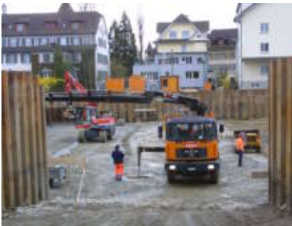
April 2002: Baugrube bereit für Beginn der Baumeisterarbeiten.
