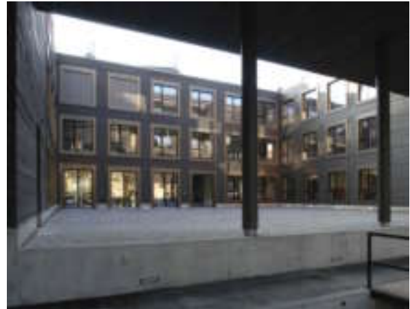
Im Nordosten vom EG bis zum 2. OG offener Innenhof.
