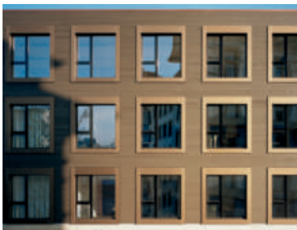
Nach Beendigung der Innenausbauarbeiten ist das Gebäude Ende 2002 bezugsbereit.
