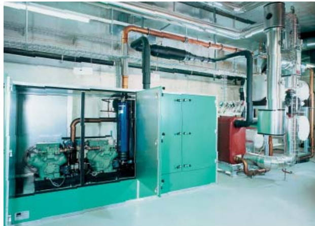
Abbildung 3. Die AED AW- Elektrowärmepumpe liefert den Strom direkt vom Gasmotor-Blockheizkraftwerk im Nachbarn (Foto: Peter Muri Zürich)
