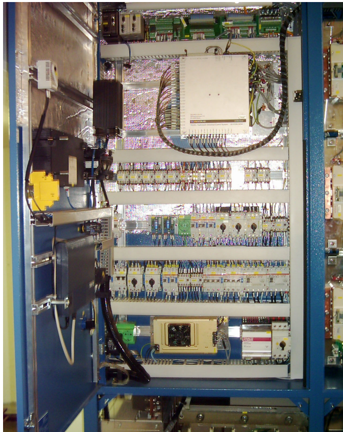
Fig. 2: Detail-Ansicht des Control-Feldes des 1.2 MW Umrichters (Quelle: Technocon AG )
