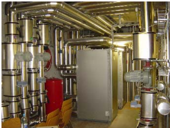
Technikzentrale mit den beiden Absorptionskältemaschinen
