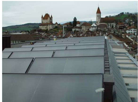
Kollektorfeld 100 m 2 auf dem Dach des Gebäudes
