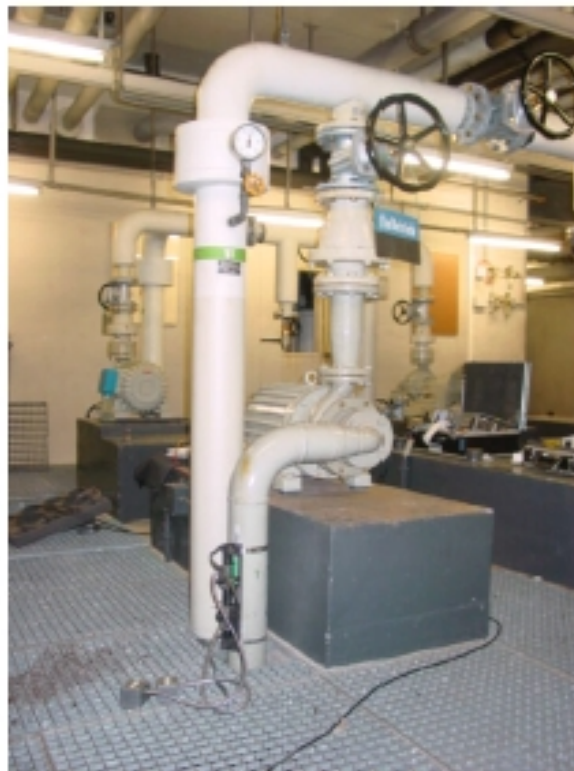
Fig.3 Durchflussmessenrichtung an Druckerhöhungspumpe
