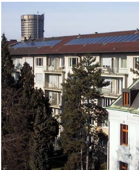
Fig. 2: 4 x 20m² WW Solaranlage, St. Jakobstr. 29; Lange Gasse 1, 3, 5; BS
