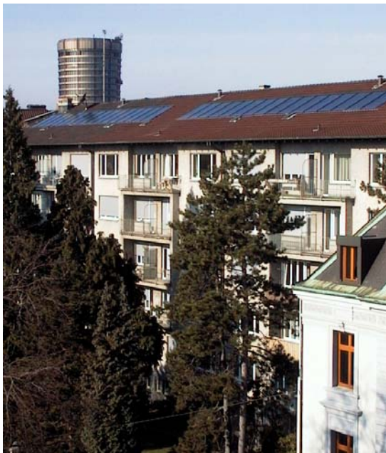
Fig. 1: 4 x 20m 2 WW Solaranlage, St.Jakobstr. 29; Lange Gasse 1, 3, 5; BS
