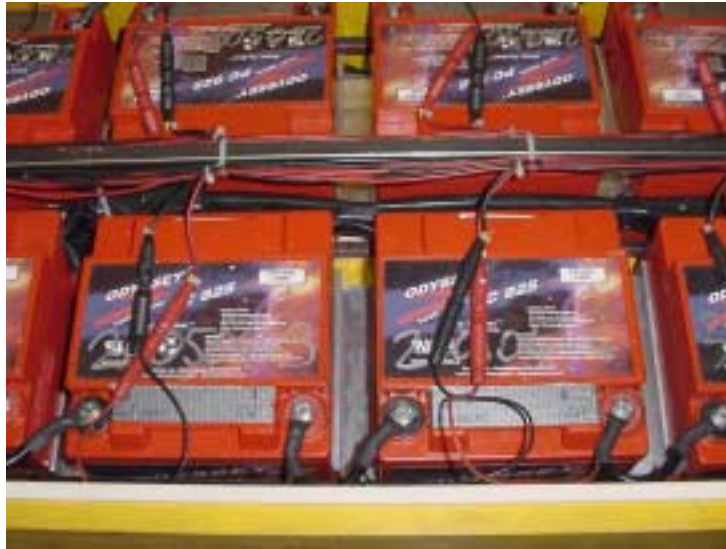
Bild 2: Bei der Batterie 260504 wurde zwischen die Batterieblöcke eine Abstützung eingebaut. Die ganze Batterie wird mit einem Spannsatz vorgespannt. Damit soll ein übermässiges Wachsen der positiven Platten verhindert werden.
