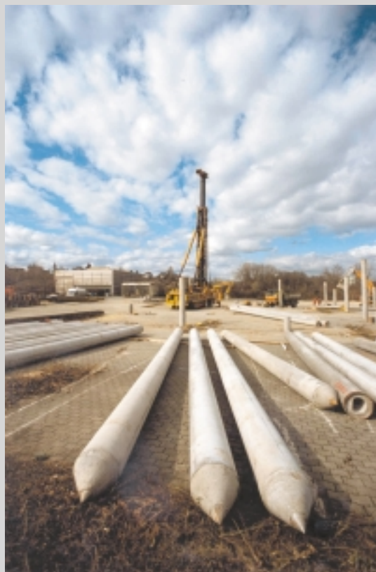
Pieux centrifugés munis d'une pointe en fonte
