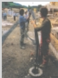
Implantation du circuit de tubes en U dans la cavité centrale du pieu.
