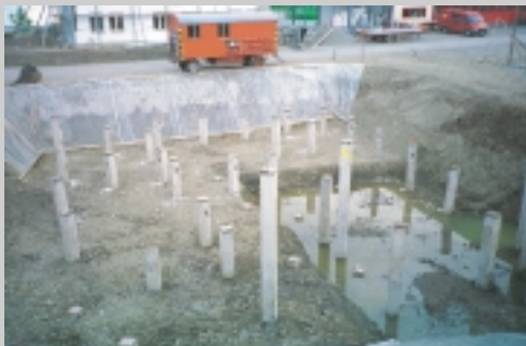
Les 42 pieux de fondation
