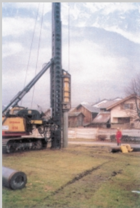
Battage d'un pieu de fondation
