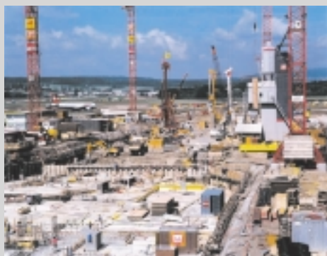
Vue d'un grand chantier de pieux énergétiques
