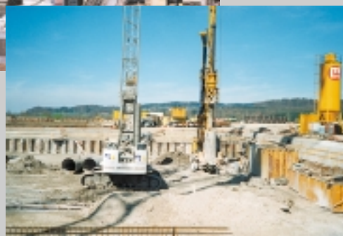
Le chantier de forage des pieux
