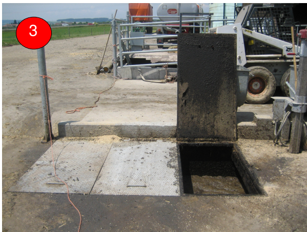
Abbildung 3: In der Vorgrube mit einer Kapazität von 90m 3 werden Substrat und Co-Substrate gemischt, gespeichert und in einen pumpfähigen Zustand versetzt, bevor sie in den Fermenter gepumpt werden.
