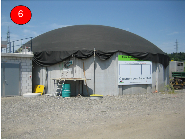
Abbildung 7: Mit dem Nachgärer (Inhalt: 840\text{m}^3 ) wird die Verweilzeit des Substrates erhöht. Unvergorenes Restmaterial kann abgebaut werden, was sich positiv auf die Gülleeigenschaften auswirkt.
