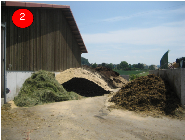
Abbildung 2: Die zugeführten organischen Reststoffe (Co-Substrate) werden im Co-Substrat-Lager aufbewahrt bis sie der Vorgrube beigegeben werden. Es werden etwa 1'000 Tonnen Co-Substrate pro Jahr angeliefert.
