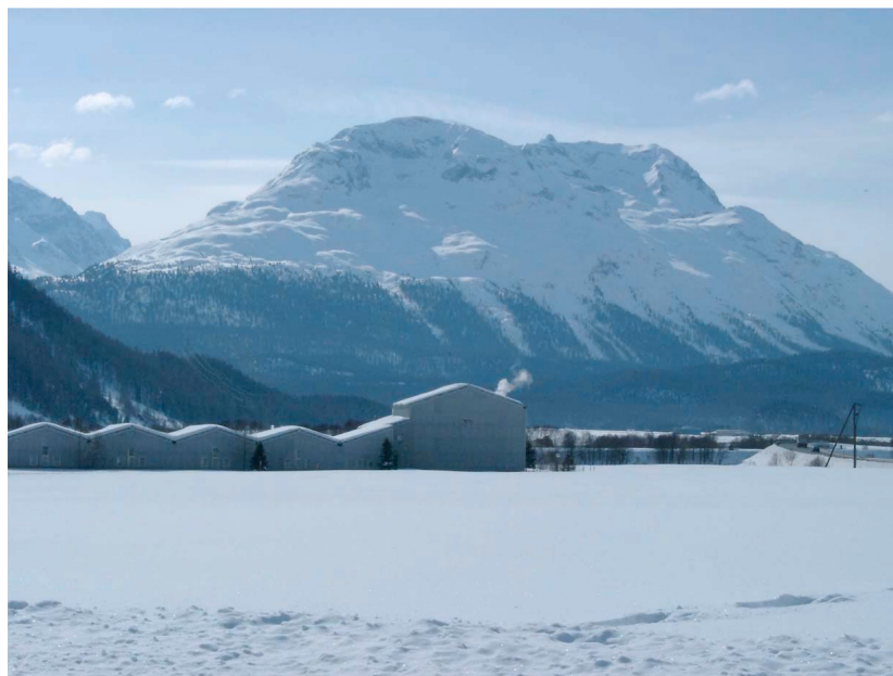
Bild 3 : Ara Sax mit Vorklärbecken, Belebungsbecken und Betriebsgebäude mit Faulturm, Stapelraum und BHKW. Die aufsteigende « Rauchfahne » weist auf das in Betrieb befindliche BHKW hin.
