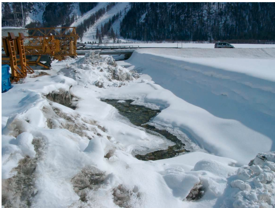
Bild 4 : Für den Bau einer Molke-Leitung zwischen der LESA und Ara Sax müssen Strasse und Bach unterquert werden
