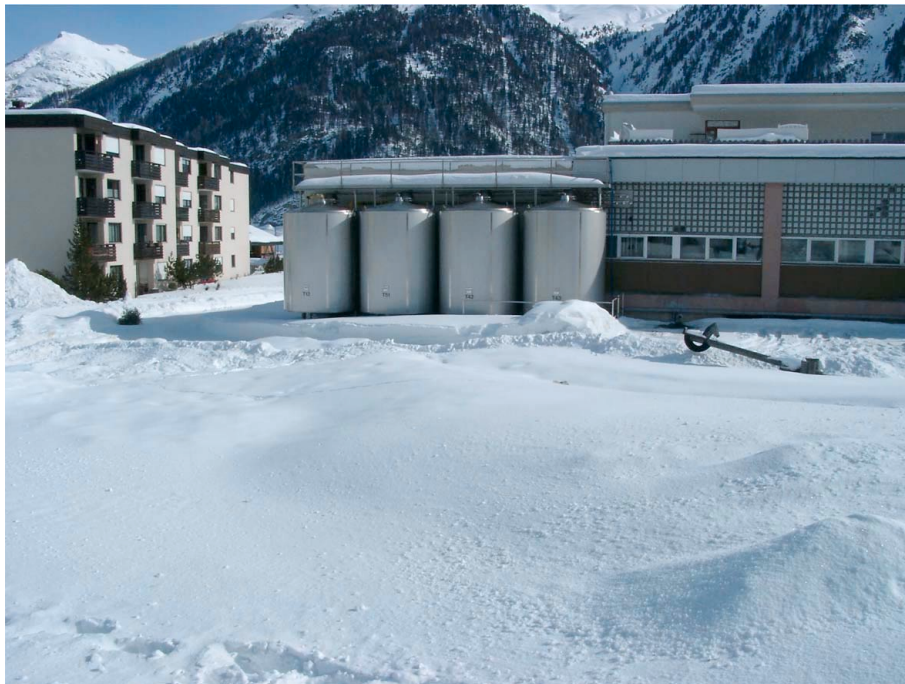
Bild 5: Drei der vier Kühltürme werden zur Zeit für die Molkeentsorgung benötigt, für Fettmolke, Magermolke und Konzentrat. Der vorgeschlagene Entsorgungspfad via Ara Sax ermöglicht die Umnutzung zweier Kühltürme : Es wird nur noch ein Kühlturm als Zwischenlager für Fettmolke benötigt, eine Kühlung ist allerdings nicht nur unnötig, sondern sogar unerwünscht
