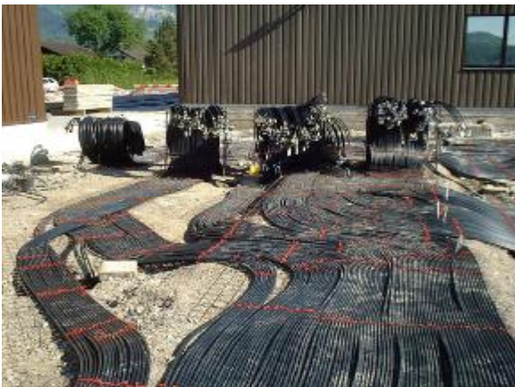
Horizontale Verteilung mit Verteilervorbereitung
