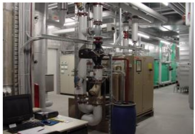
Kältemaschine mit Auswertungsplatz (unten links)
