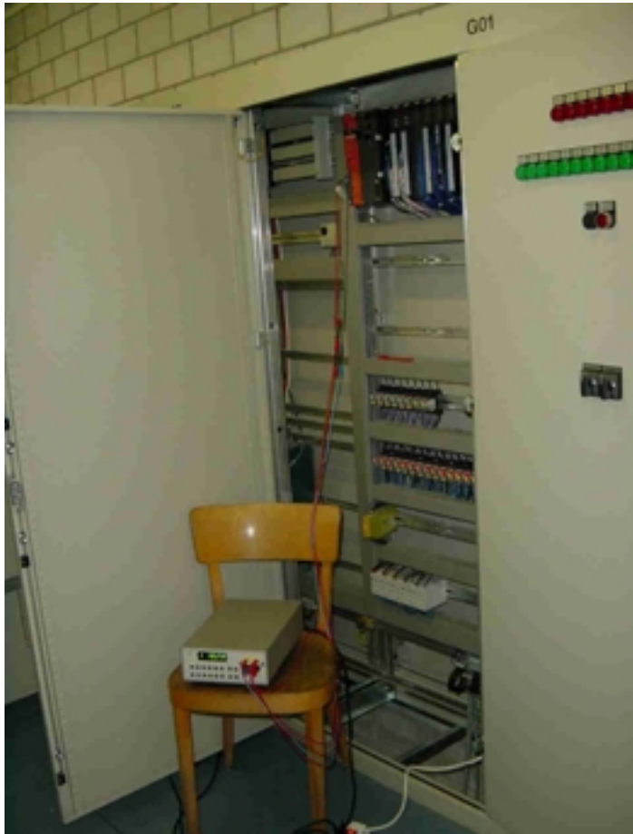
Figur 13: Schaltschrank mit Leistungsmessgerät Entwässerungsanlage ARA Chur
