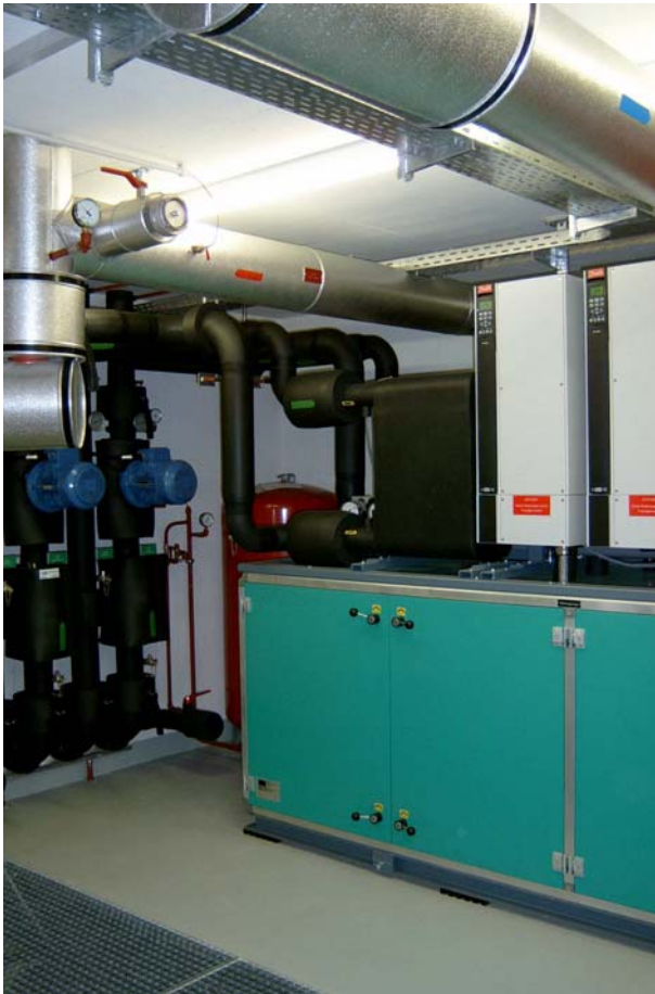
Abbildung/Tabelle 16 Kältegruppe und Wärmepumpe, Sondenverteiler
