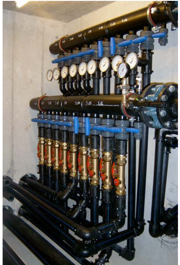
Abbildung/Tabelle 16 Kältegruppe und Wärmepumpe, Sondenverteiler
