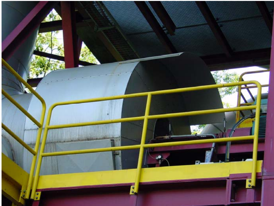
Bild 2: Saugzugventilator
