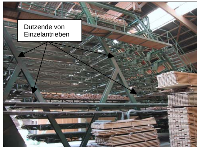
Abbildung 2.13: Sortierwerk Springer Leistung pro Motor ca. 3kW
