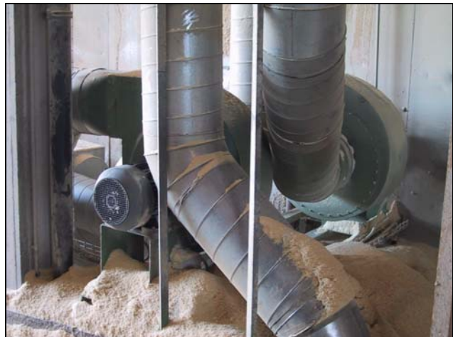
Abbildung 2.23: Die hohen Druckverluste bedingen mehrere Ventilatoren hintereinander.
