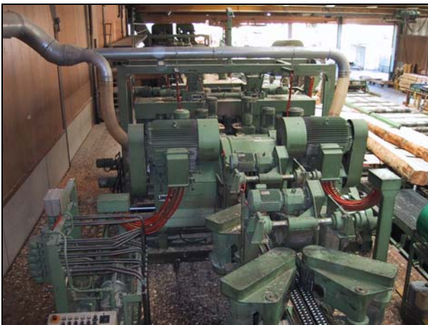
Abbildung 2.9: Zerspaner 1 der Profilzerspananlage
