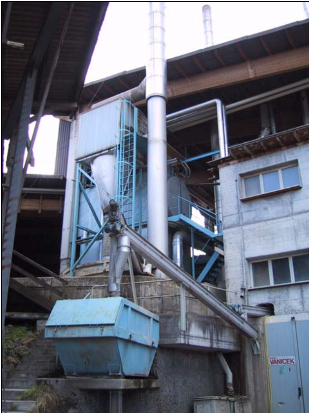
Abbildung 2.25: 5 MW Holzessel mit Zyklonabscheider und Aschemulde.
