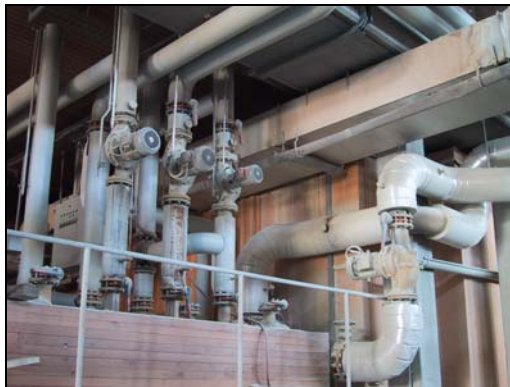
Abbildung 2.26: Die Wärmeverteilung erfolgt mit Haupt- und Zwischenpumpen.
