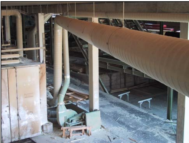
Abbildung 2.22: Ein verzweigtes, langes Netz verursacht hohe Druckverluste.
