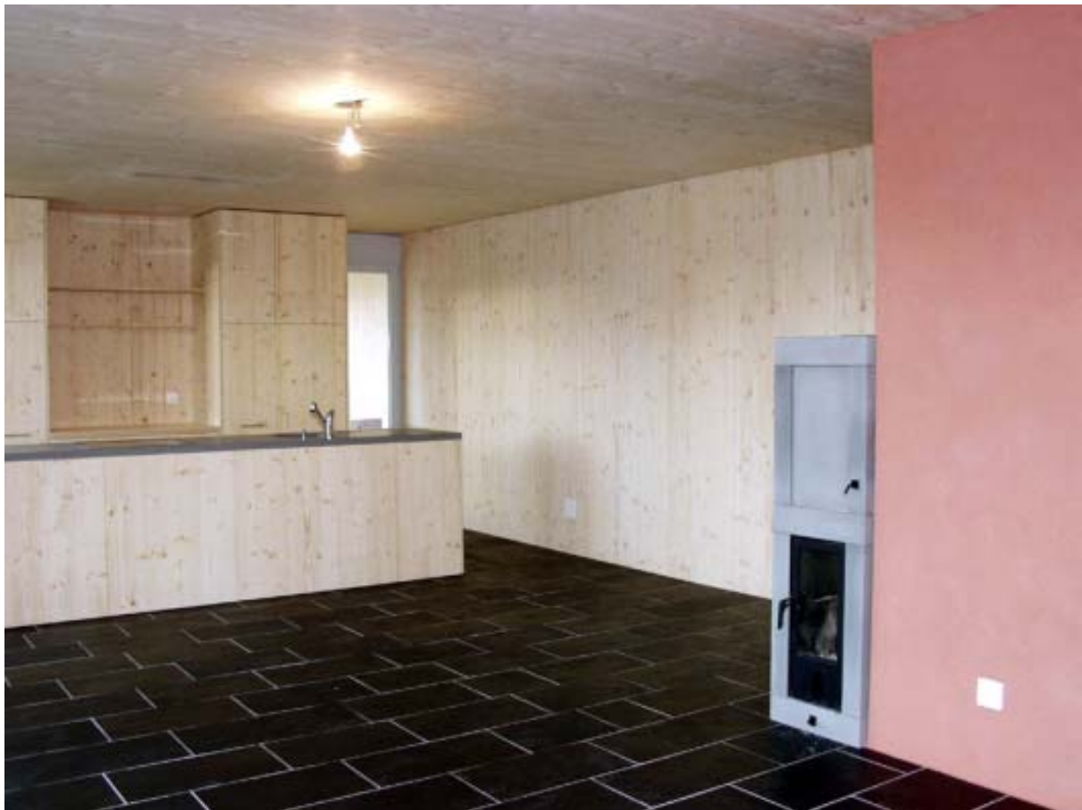
Abbildung 2-19: Der mit schwarzem Schiefer belegte Speicherboden (Hypokauste), der kleine Holzspeicherofen und die Murokauste (rötlicher Verputz) mit Verteil-dose (weisser Deckel) für den Temperaturfühler des Bodenspeichers.
