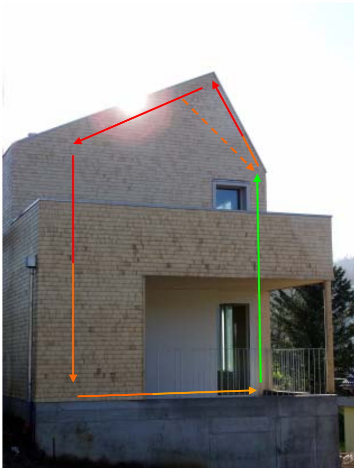
Abbildung 2-14: Nordwestseite mit angedeuteter, schematischer Luftführung durch das Innere der Gebäudestruktur (Sommerbetrieb: gestrichelt).
