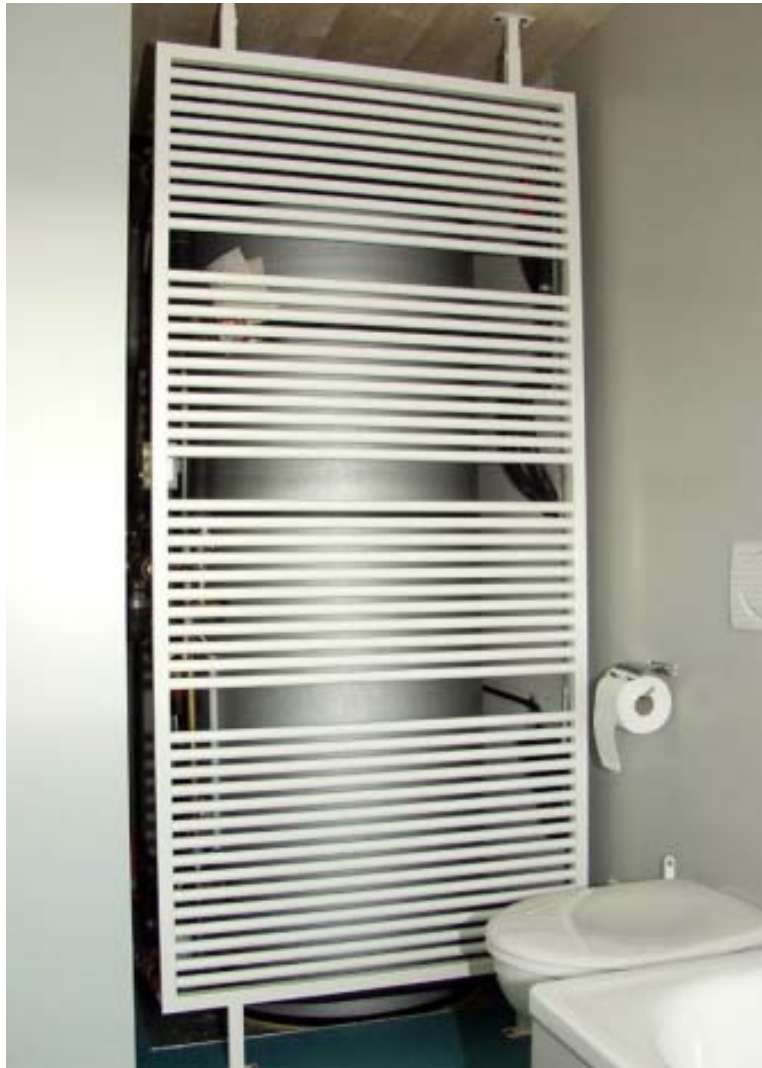
Abbildung 2-25 Solarboiler hinter dem Handtuchradiator, Ansicht aus dem Badezimmer
