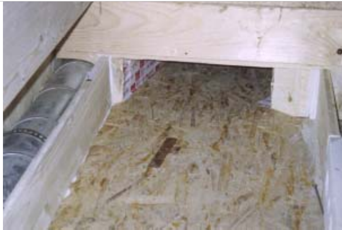
Abbildung 2-22: Ausschnitte aus den Sammel- und Verteilkanälen der Hypokauste.
