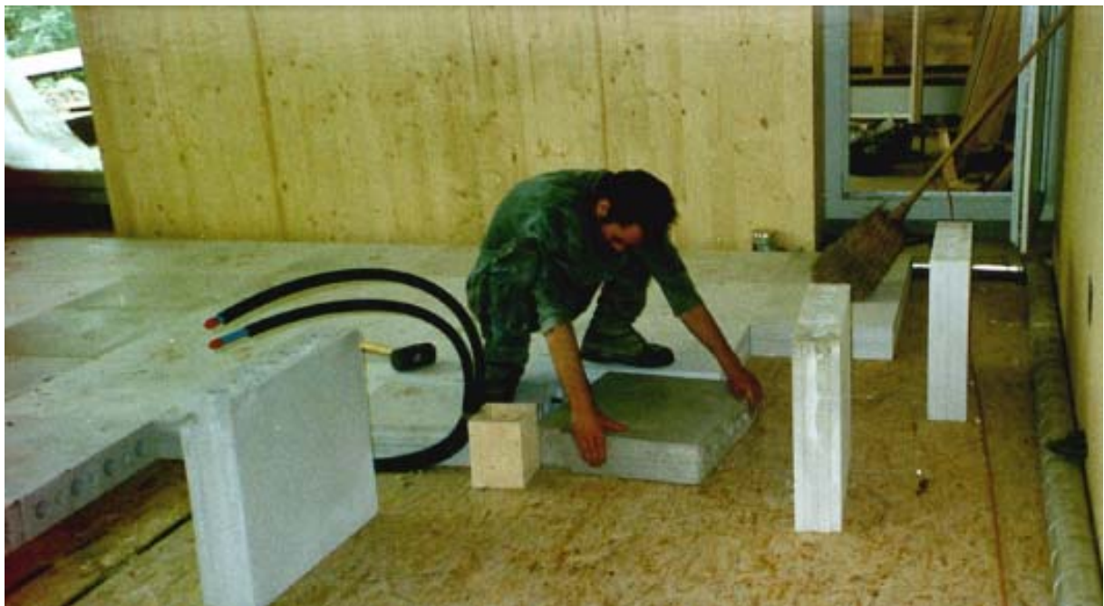
Abbildung 2-20: Zusammenfügen der Hohlsteine zu einer Hypokauste auf den tragenden Holzelementen der Bodenkonstruktion.
