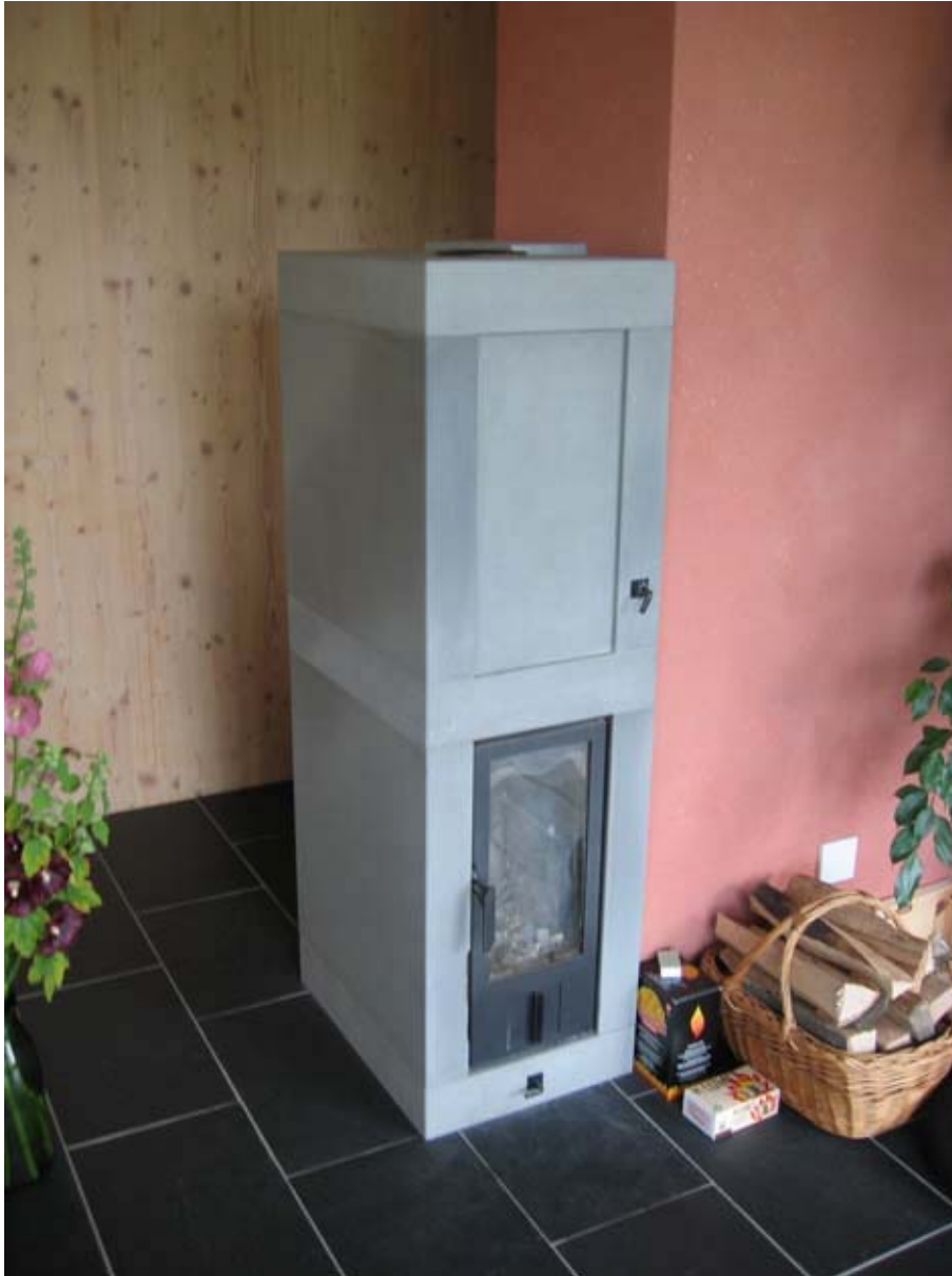
Abbildung 2-26: Holzspeicherofen. Das Wasserregister befindet sich im oberen Speicherteil.
