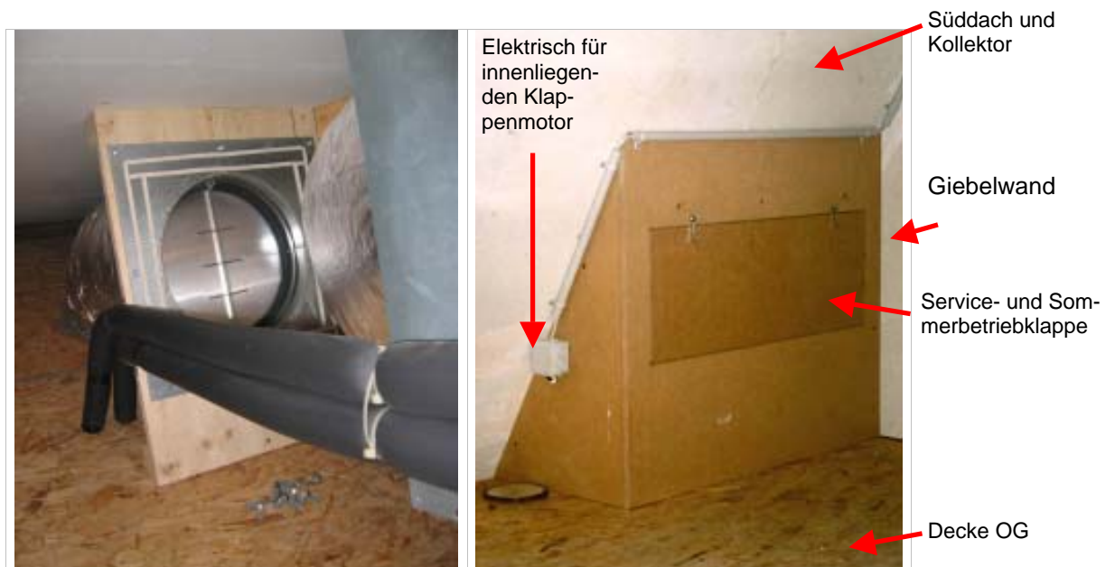
Abbildung 2-18: Federbelastete Rückschlagklappe im Vorlauf nach dem Ventilator (links); Verkleidung des Rücklaufdurchbruchs in den Kollektor und der motorisierten Rücklaufklappe mit Serviceöffnung .
