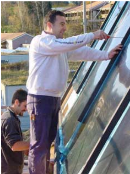
Abbildung 1: Montage des selektiven Absorbers. Das Glashalteprofil und das Solarglas wird danach auf die schwarz eingefärbte Unterkonstruktion montiert. Die Lufteintrittsöffnung (noch nicht schwarz eingefärbt) ist links unten sichtbar.
