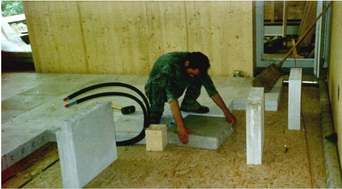
Abbildung 2: Verlegen der KS-Hypokauste auf der tragenden Bodenkonstruktion aus wärmege- dämmten Holzelementen. Der freie Platz rechts ist der Verteilkanal für den Vorlauf des solaren Luftsystems. Zudem wurde dort auch ein Lüftungsrohr verlegt. Ab- schliessend wurden noch ein Unterlagsboden aufgebaut und Steinplatten als Fussboden verlegt.
