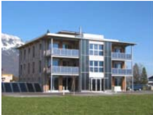
Südfassade Synergiepark PV – Anlage in Balkon integriert Flachkollektoren Doma 30m 2 90° Flachkollektoren Stiebel Eltron 27m 2 Neigung 45
