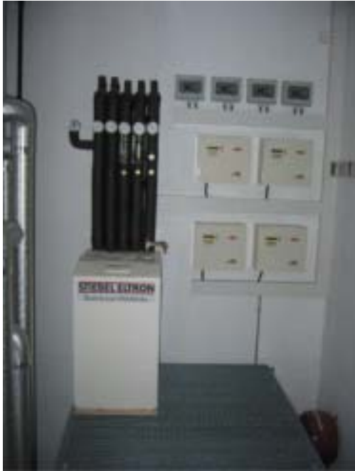
Wärmepumpe WPF 13 4 Wechselrichter Photovoltaik
