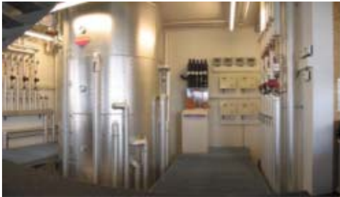
Technikzentrale im Erdgeschoss: rechts im Bild Vor-/ Rücklauf der thermischen Kollektoren, an der Wand hinten die Wechselrichter, links davon die WP der Erdsonden, links des zentralen Speichers Wärmeverteilung für das ganze Gebäude
