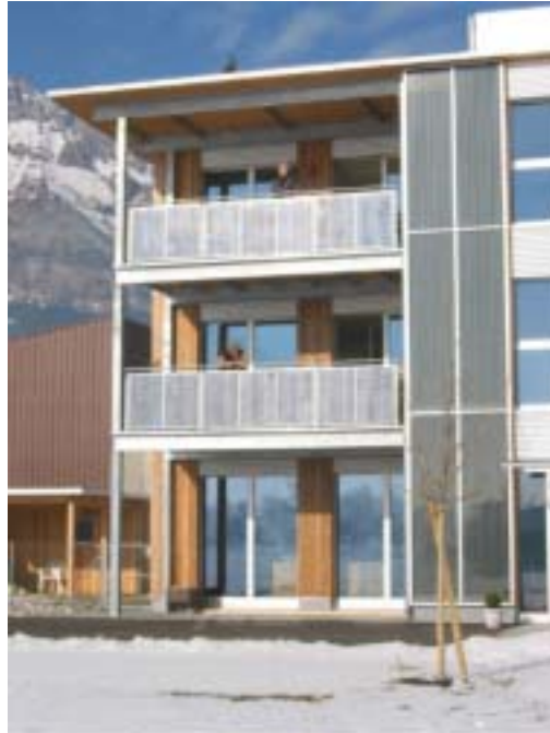
Thermische Kollektoren Typ Doma Balkongeländer Photovoltaik Typ „Kyocera“
