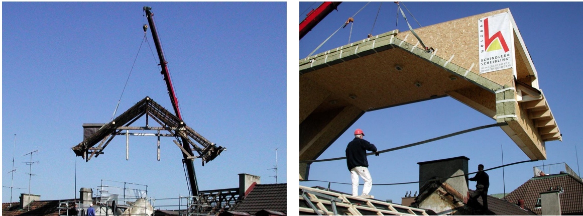
Fig. 3 + 4, Abbruch des alten Dachstuhles und Versetzen der Dachelemente von Haus 9
