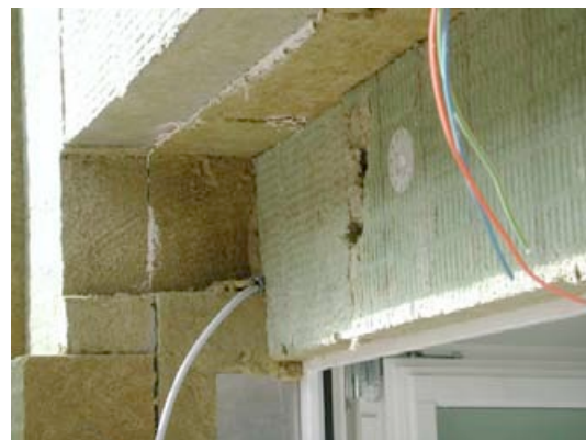
Fig. 33: Ausbildung der Rollladenkasten
