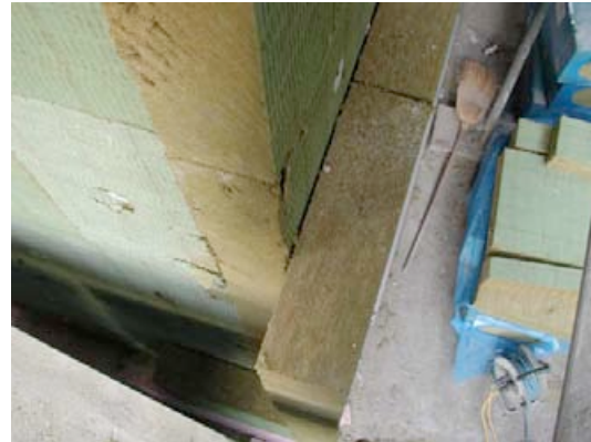
Fig. 32: Schichtweises Aufbringen der Dämmplatten
