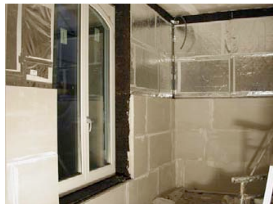
Fig. 21: Gipswand wird als Schutz vor der VIP hochgezogen.
