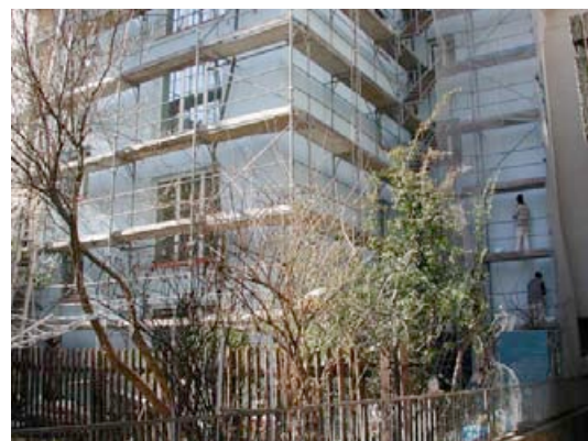
Fig. 34: Verputzen der Aussenwärmedämmung
