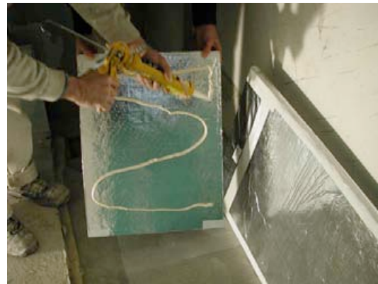
Fig 19: Kleben der Vakuum-Dämmplatten
