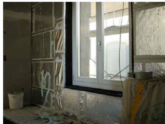
Fig 20: VIP aufgezogen, Leibung mit Kork gedämmt
