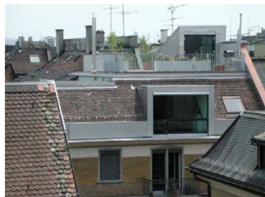
Fig. 28: Die fertig verkleidete Lukarne bei Bauabschluss
