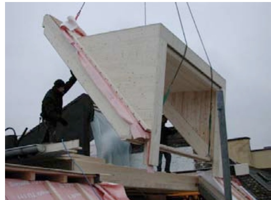
Fig. 27: Montage der Lukarne auf der Baustelle
