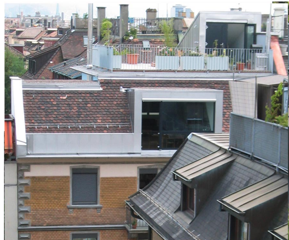
Fig. 3, Dachstock mit neuer, grosser Lukarne
