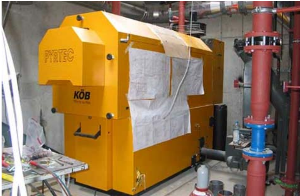
Abbildung 2: Montage des Holzkessels, Foto [6]
