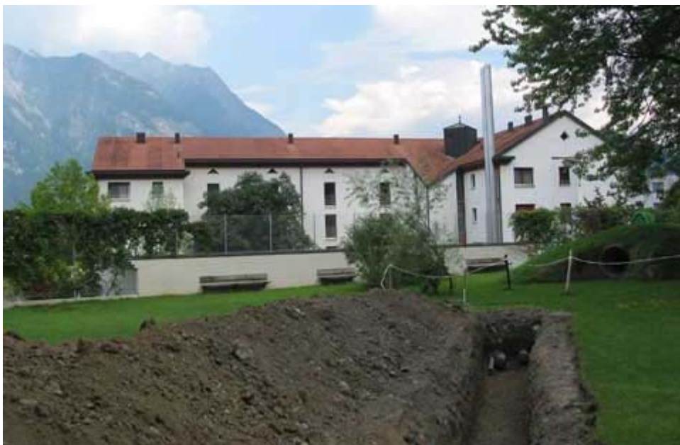
Abbildung 3: Vergraben der Fernleitung, im Hintergrund das Gebäude mit der Heizzentrale, Foto [6]
