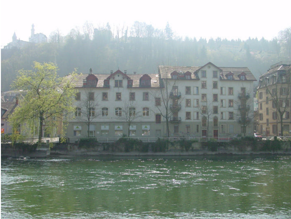
Abb. 3: Ansicht der Liegenschaften Sentimattstrasse 7, 8 und 9
