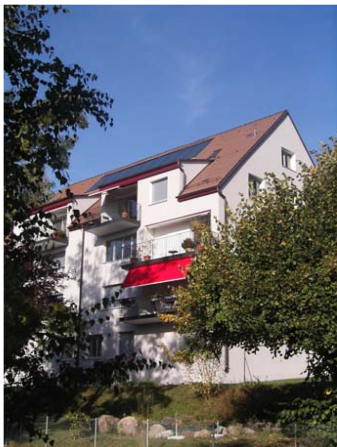
Solaranlage auf Gebäude Drusbergstrasse 14, von Süden
