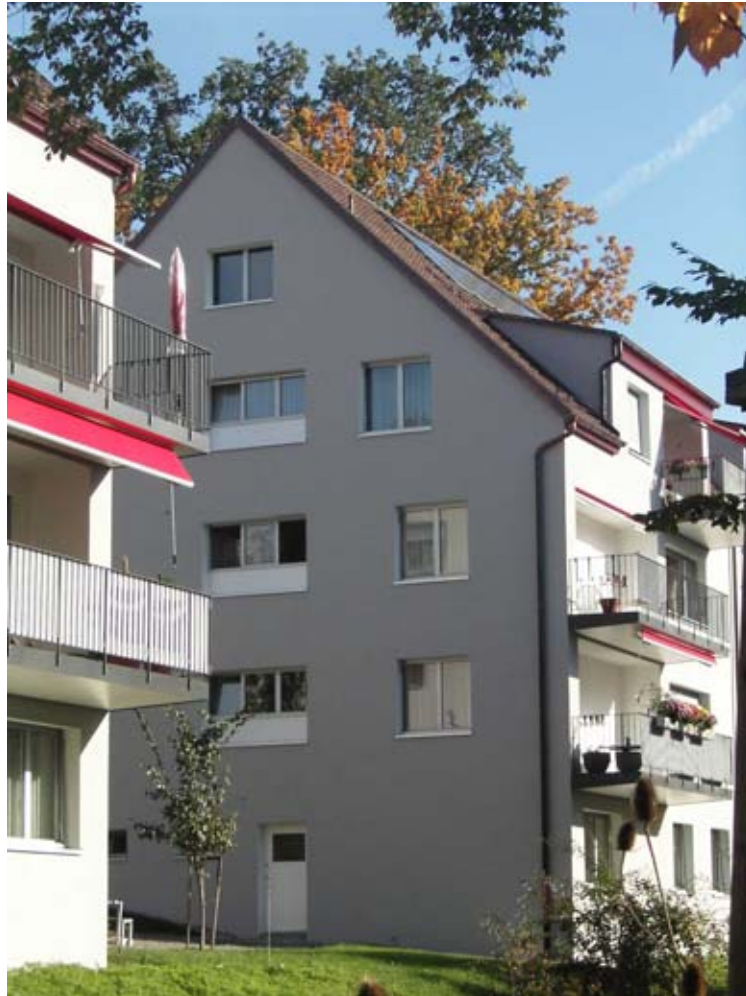
Solaranlage auf Gebäude Drusbergstrasse 21, von Westen
