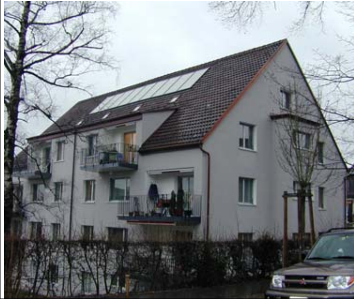
Solaranlage auf Gebäude Drusbergstrasse 32, von Osten
