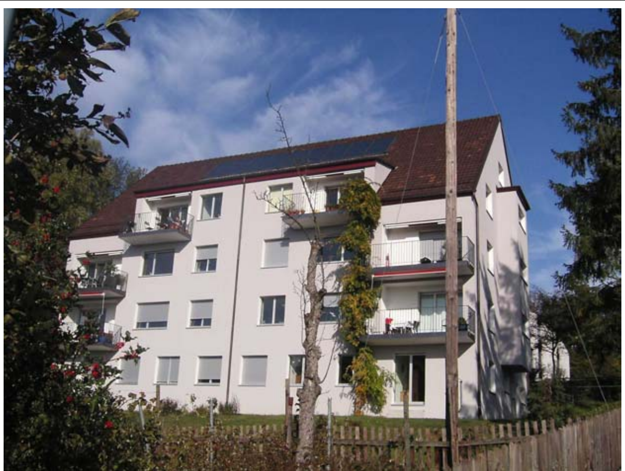
Solaranlage auf Gebäude Drusbergstrasse 36, von Südwesten
