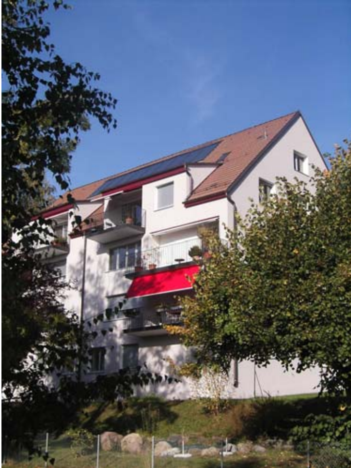
Abbildung 3.3 Solaranlage des Gebäudes Drusbergstrasse 14, Ansicht von Süden
