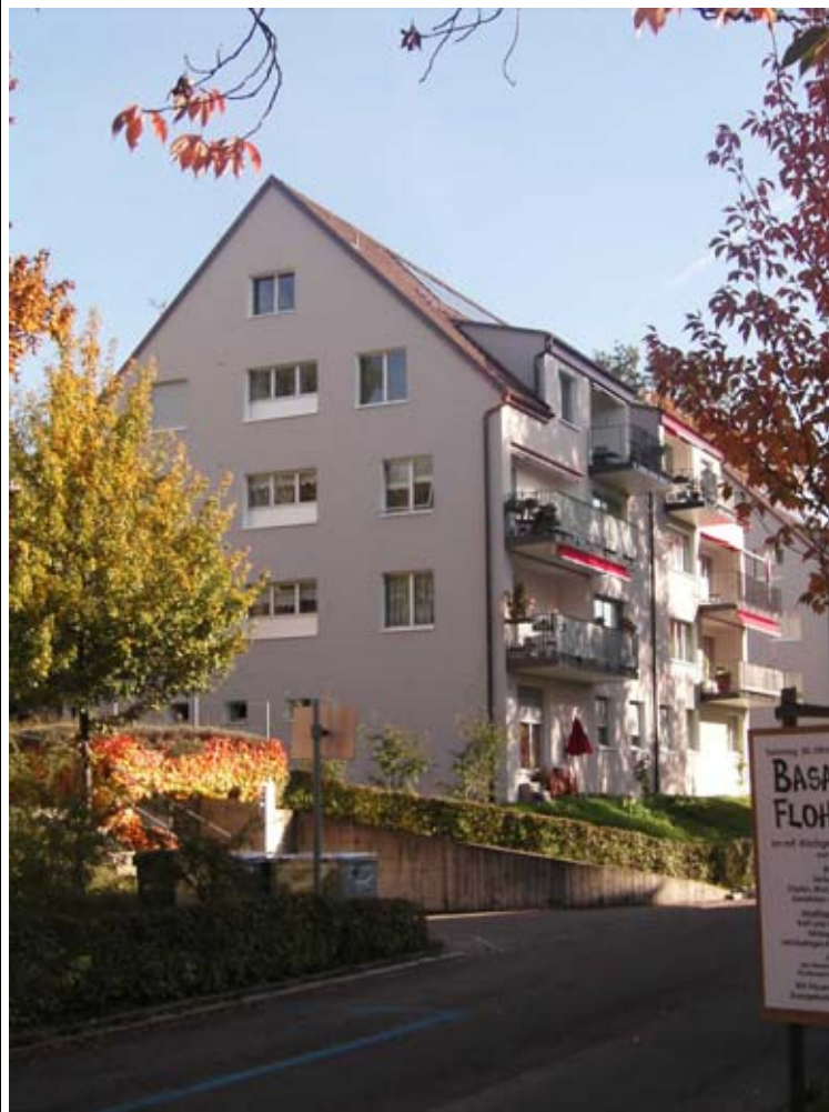
Solaranlage auf Gebäude Drusbergstrasse 17, von Westen
