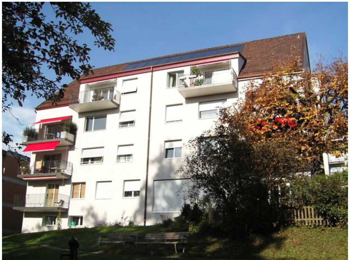
Solaranlage auf Gebäude Witikonstrasse 232, von Westen
