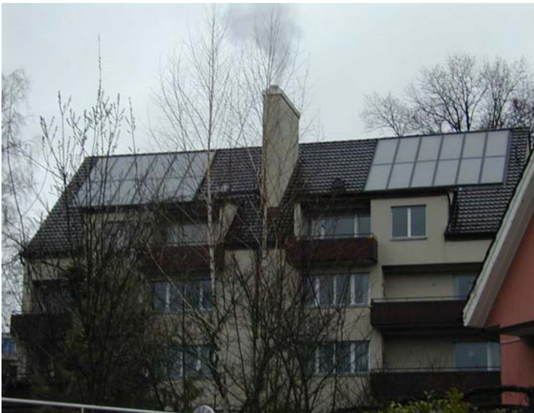
Abbildung 3.6 Solaranlage auf dem Gebäude der Heizzentrale, Drusbergstrasse 22, Ansicht von Südwesten
