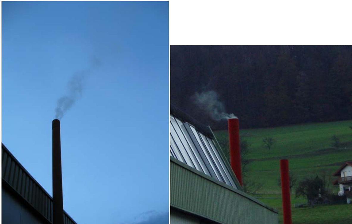
Bild 6: Deutlich sichtbare Rauchfahne beim Betrieb von Ofen 1 unter schlechten Bedingungen.
