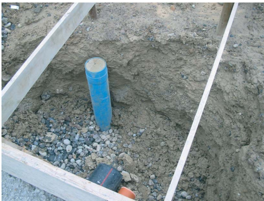
Einbau des Rückgabebrunnens mit Zuleitung
