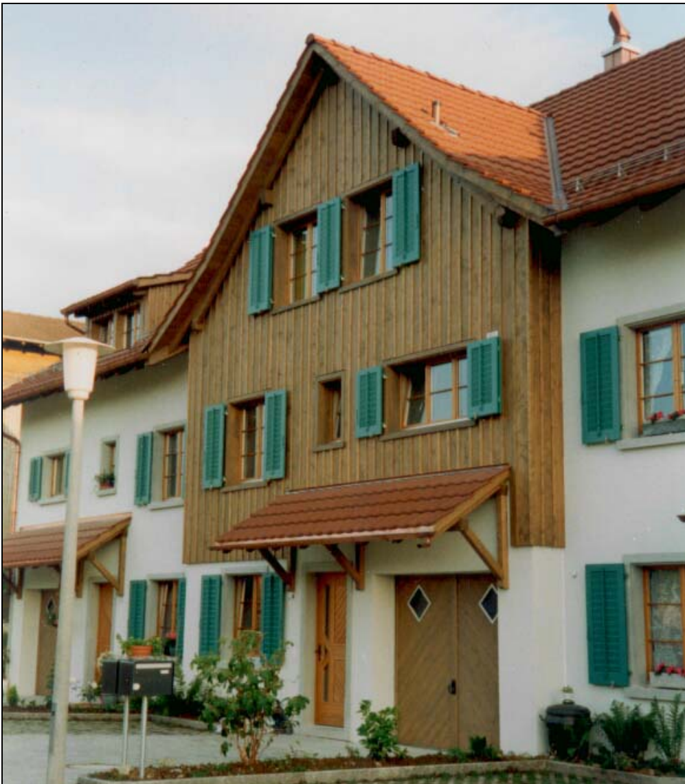
Abbildung 2: Versuchsanlage Waltalingen Ziletten, Ansicht von Norden
