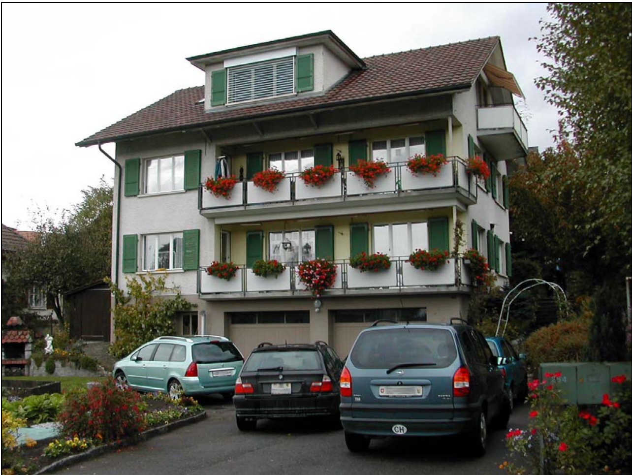
Abbildung 21: Versuchsanlage Richigen, Ansicht von Südwesten
