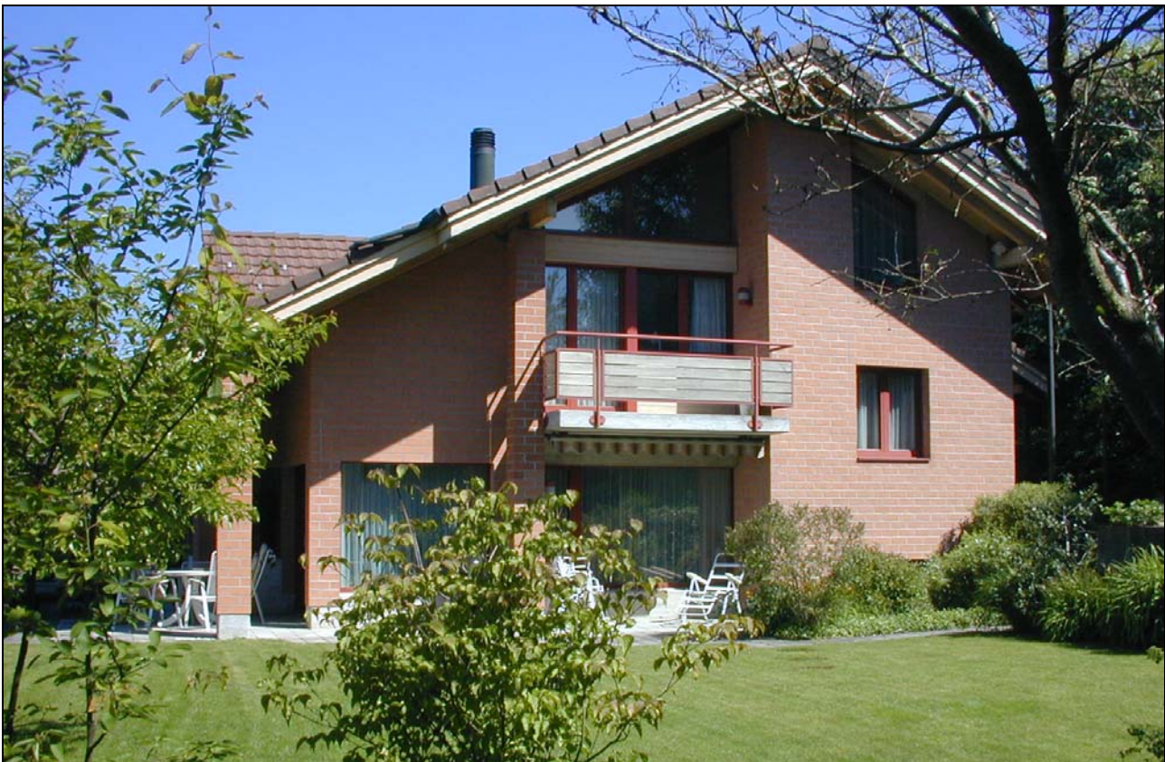
Abbildung 12: Versuchsanlage Seen, Ansicht von Südosten; das Wohnzimmer (grosse Fenster im EG) bekommt morgens und nachmittags Sonne, das Büro auf der Nordseite bekommt keine Sonne
