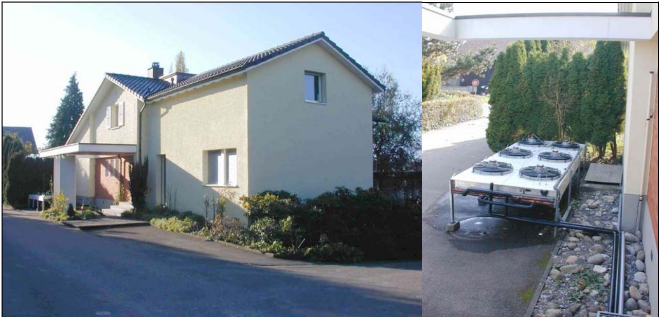
Abbildung 15: Versuchsanlage Münsingen, Ansicht von Norden; der Luftkühler (Bild rechts) steht links neben dem Eingang auf einem Parkplatz
