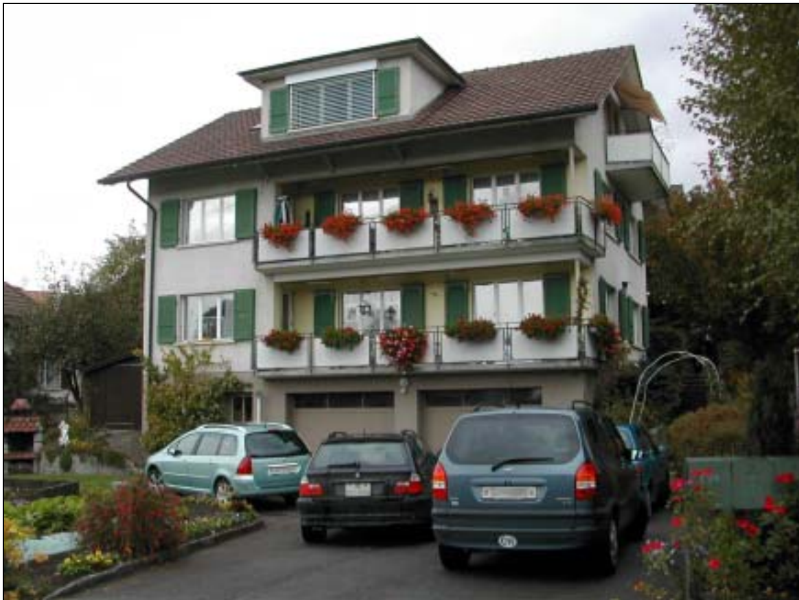
Bild 1: Versuchsanlage «Richigen», Ansicht von Süden
