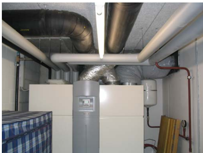
fig. 1: situation of the pilot plant Stiebel Eltron LWZ 303 SOL in Gelterkinden (Kt. BL)
