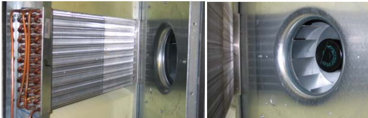
Abb. 21 Verdampfer (links) und Gebläse (rechts) des Prototypen.
