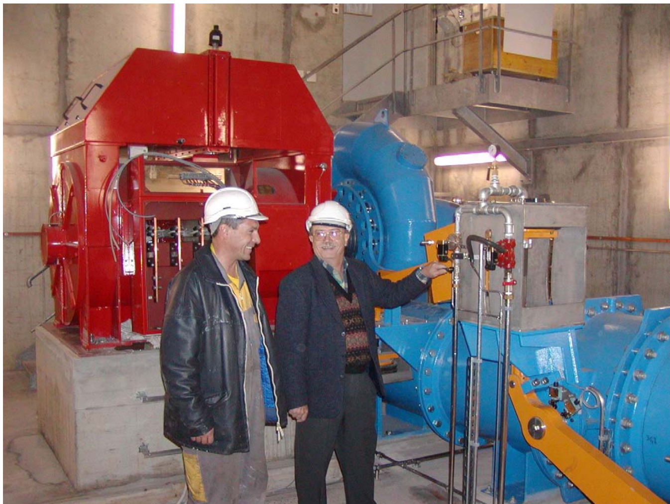
Figure 3 : Vue de la commande hydraulique de la vanne de sécurité et du distributeur
