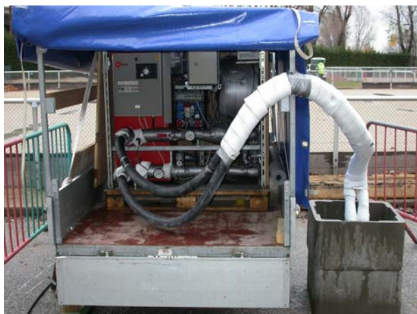
Figure 8: Détail de l'isolation des tuyaux par des bandes en mousse.
