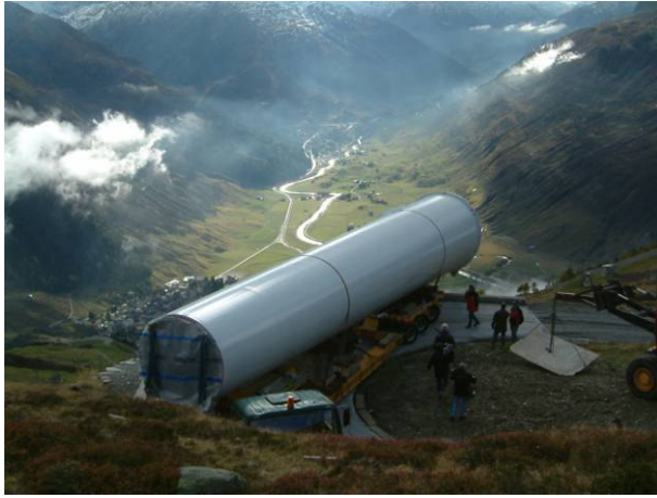
Abb.4: Transport eines Turmsegmentes auf den Gütsch (CH)
