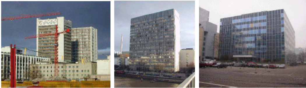
Fig. 1 Die drei untersuchten Novartis-Bauten (Bild: Semafor)
