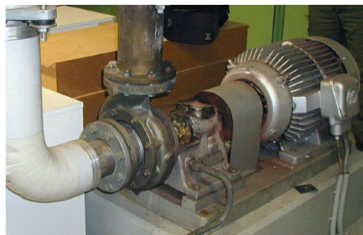
Fig. 2 Druckerhöhungspumpe im Bau WKL 127 (Bild: Semafor)
